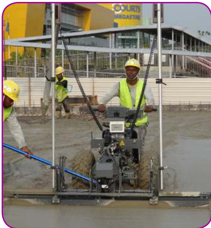
Mini Screed™ C on the job
